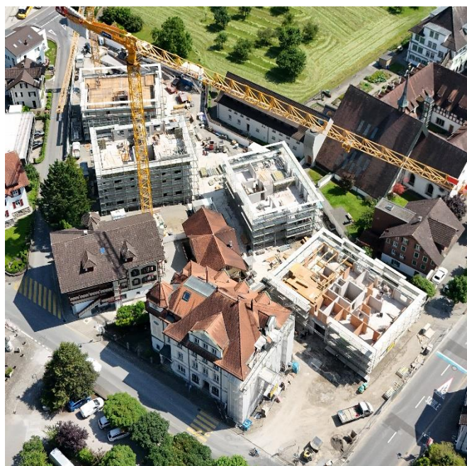
Mit jedem Tag verändert sich das Bild auf der Baustelle.
