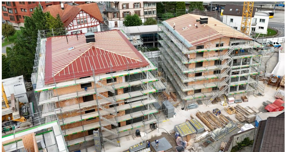
Die zwei Gassenhäuser sind bereits eingedeckt.
